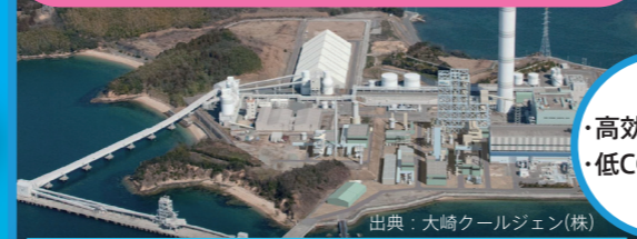
出典：大崎クールジェン(株) ▶ 石炭ガス化燃料電池複合発電 (IGFC)
