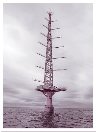
風車の運用データを取得する観測タワー。風速計から鳥類レーダーまで、50基以上の観測装置が取り付けられている。
