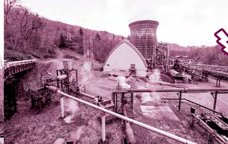
発電所の敷地内には、蒸気を送るためのパイプが縦横に走っている。三角屋根の建物にタービンと発電機のある発電棟。その向こうにそびえているのが、高さ46mの冷却塔だ。
