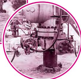
生産井の地表部分。周囲をコンクリートで固め、太いボルトでパイプがしっかりと固定されている。
