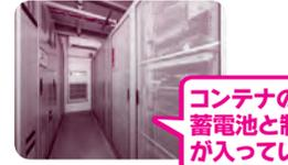
コンテナの中に蓄電池と制御盤が入っている
