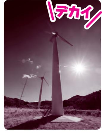
風力発電機は、高さ41.5mの柱の上に、長さ16mのブレードが3枚ついている。下にあるコンテナは、つくった電気をためておくための蓄電池だ。新島は外洋に面しているため、普段から風が強く、風力発電にはうってつけ。
