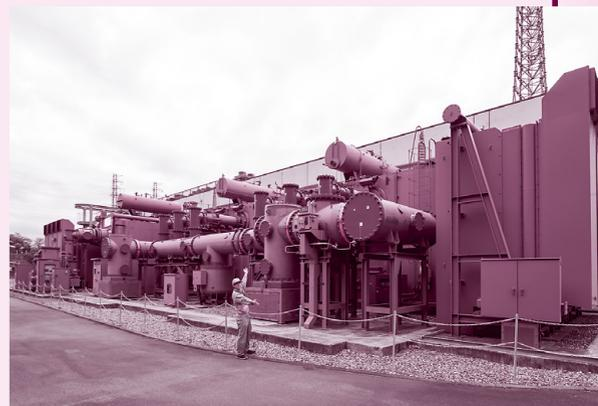
この巨大メカは、電気をサイリスタバルブの運転に適した電圧に調整する装置(変換用変圧器)。達人と比べるとその大きさがわかる。
