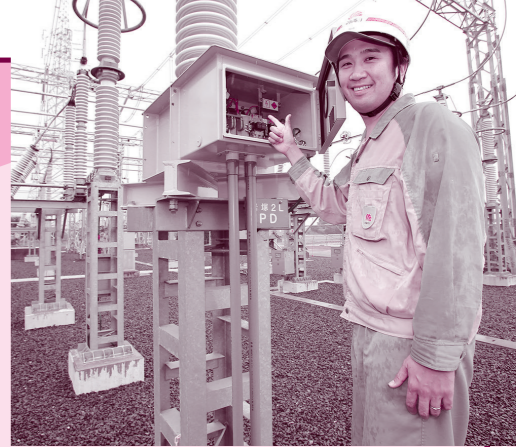
機械の点検作業を行う田中さん。すぐに手が届くようなところにはないけど、後ろに見えるむき出しの電線には高圧の電流が通っている。危ないので一般の人は立ち入り禁止だぞ!
