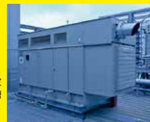
屋上に設置された非常用自家発電装置。停電時には水槽専用の電源として使用される。(写真提供/すみだ水族館)
