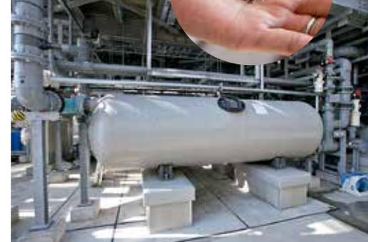
ろ過タンクの中には目の細かい砂(写真右上)と特殊なバクテリアが入っている。このタンクに水槽内の汚れた水を通し(24時間で15回循環)、水中の汚れを除去・分解する。
