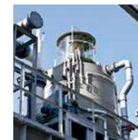
ろ過装置のほかにも「プロテインスキマー」という海水の浄化装置も設置。タンクの中で細かい泡を発生させ、水槽の水に含まれる微細な汚れ(微生物や細菌などを吸着して取り除く)を除去する。
