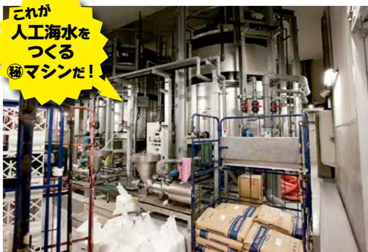
水槽の水は地下にある「人工海水製造システム」で製造。タンク内のスクリーナーで水道水と塩を1時間ほどかき混ぜて、塩分濃度約3.5%の人工海水をつくり、いったん地下の貯水槽にためてから各水槽にポンプで送られる。このタンク1つで、1回に約7tの人工海水が作られるぞ!
