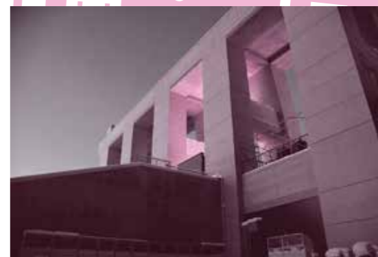
重さが約1万tもある巨大な三角屋根を開けるときは、この高架の上からスライドしてくる。開け閉めにかかる時間は25分ほどだ。
