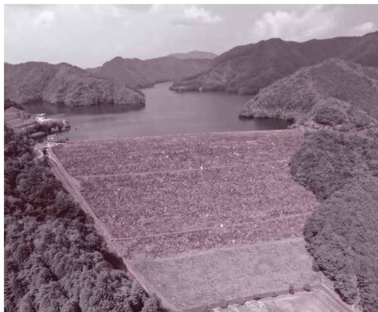
▶黒川ダム。高さは98mと多々良木ダムより高く、貯水量も多い。同じロックフィルダムだが、中央部に粘土質の土をはさむことで、水を通さないしくみになっている。電気をつくる目的のほかに、工業用水や水道用水としても利用されている。
