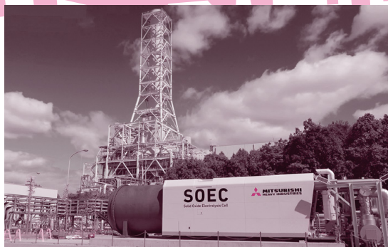
高温水蒸気電解を行う設備。水素を利用する燃料電池の技術がすでにあり、それを応用したもの。(写真提供/三菱重工業株式会社)
