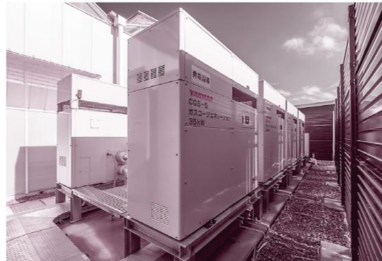
ハウスの横にはLNG(液化天然ガス)を使った発電機が並んでいる。非常用にもなるが、普段から電気をつくっていて、発生する熱やCO2もむだなく利用している。
