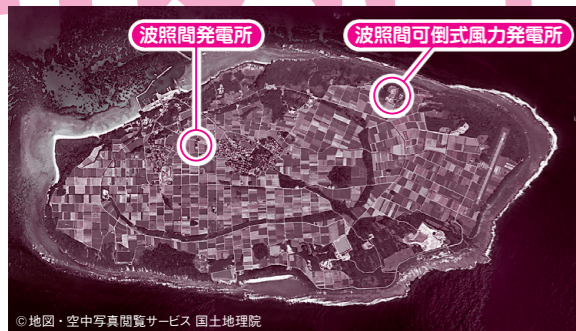
周円約15kmの波照間島は、サンゴ礁が盛り上がりできた島。意外と起伏があって、波照間可倒式風力発電所は海の近くにある。
