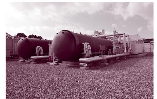
第3段階の試験で使用する固体酸化物形燃料電池。出力が600kW級のもので、1基の大きさは長さ約12m、幅は約3m。(写真提供/大崎クールジェン株式会社)
