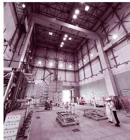
奥行き40m、幅25m、高さ29mもある短絡試験棟。周囲は厚さ1.5mの防音壁で囲まれていて、大きな電流を扱う各種の電気機器やケーブル、送電鉄塔の設備の試験まで行うことができる。大電流をわざとショートさせるので、大きな音したり部品が飛び散ったりすることもあるのだ。
