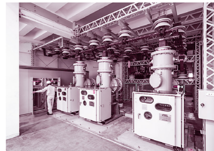
発電機でつくられた電気を送り出すためのスイッチの役割を果たす投入開閉器。
