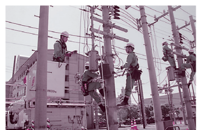
電柱の点検・保守には高い技術が必要。安全を確保しつつ、実際の電柱に登って作業する訓練が欠かせない。
