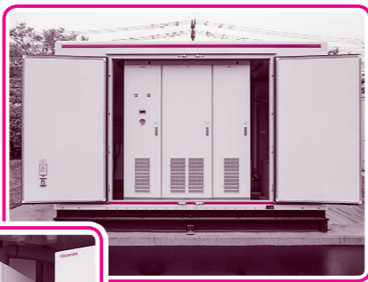
コンテナ7の中の蓄電池。中には多量のリチウムイオン電池が入っている。
