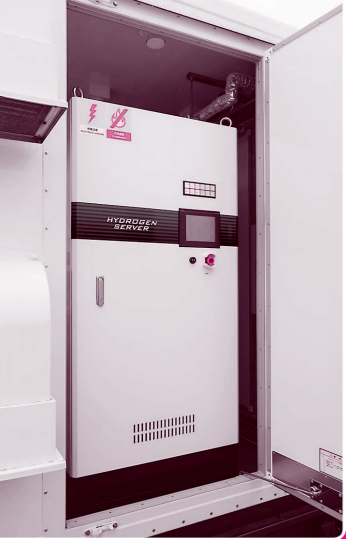
コンテナ2の中に取められた水電解装置。使われている水は不純物を一切含まない純水だ。
