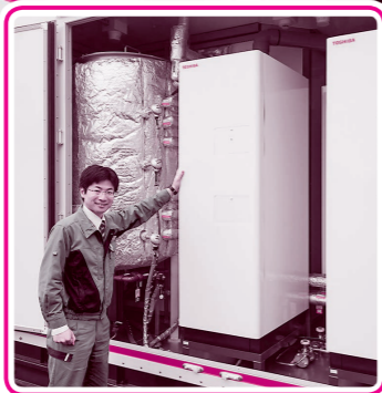
コンテナ4の燃料電池。電気をつくるときに発生するのは水で、空気を汚さない。電気自動車で「燃料電池車」と呼ばれるタイプは、これと同じくみで電気をつくっている。
