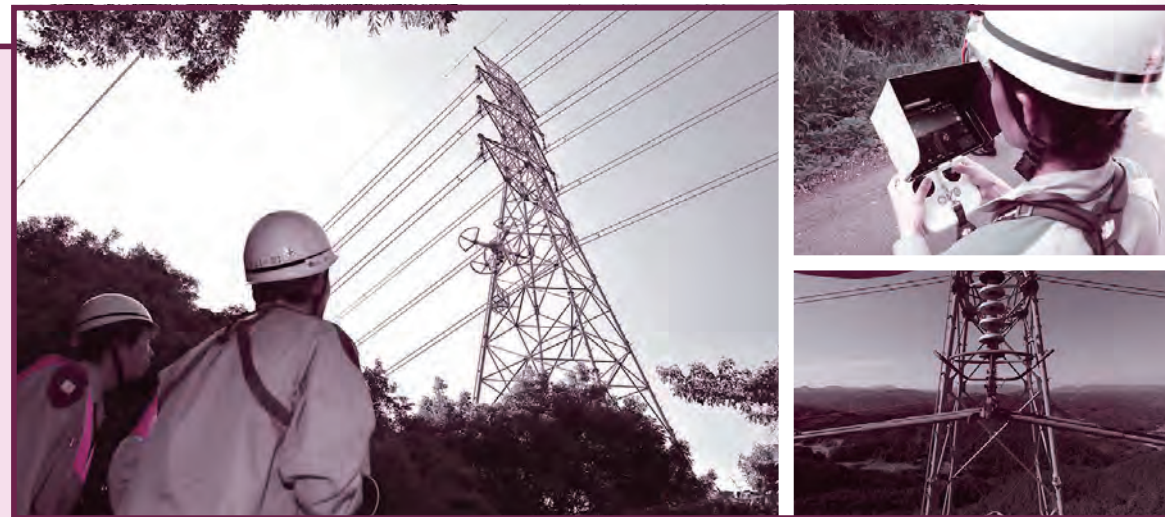
ドローンを飛ばして鉄塔の点検作業を行う達人(左写真)。鉄塔すれすれに上昇していくドローンを注意深く見守りながら、プロポに取り付けられたモニターもしっかりチェックする(右上写真)。ドローンが撮影した4Kカメラ画像(右下写真)。実機と画面の両方を見ながら自由自在に操縦するなんて、まさに達人ワザだね。
