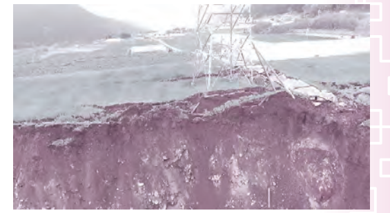
ドローンが撮影した、熊本地震による鉄塔付近の土砂崩落の様子(熊本県阿蘇市)。人間がとてもしつづくことのできない危険な場所でもドローンなら撮影することができる。撮影した画像を元に適切な対策がとられた。
